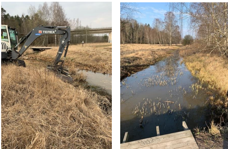
Figur 2 Rönningen av växtlighet gjordes av en maskin med ett klippverktyg. Klippning av växtlighet gjordes längst med bäckens sidor samt det som redan stack upp ur vattnet.
